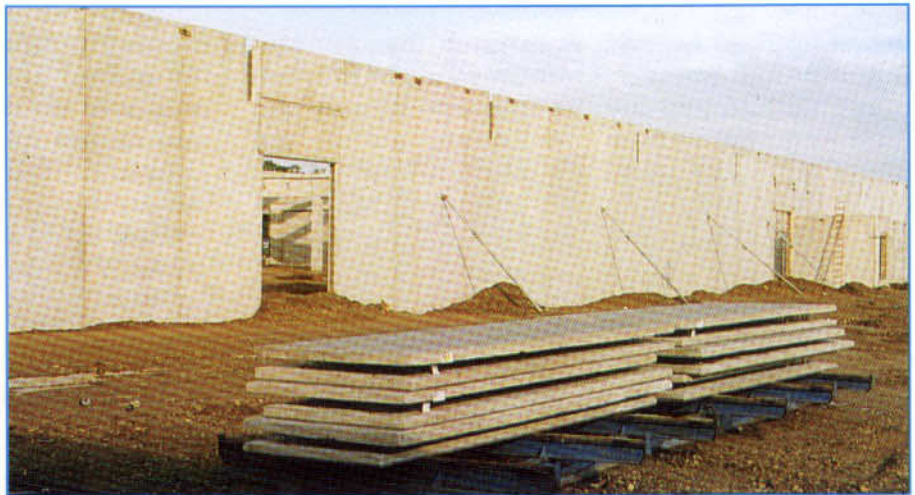
4300 m 2 Doppelwände wurden pünktlichst angeliefert und rasch versetzt. Die Einzelteile sind bis zu 7 Meter hoch.
