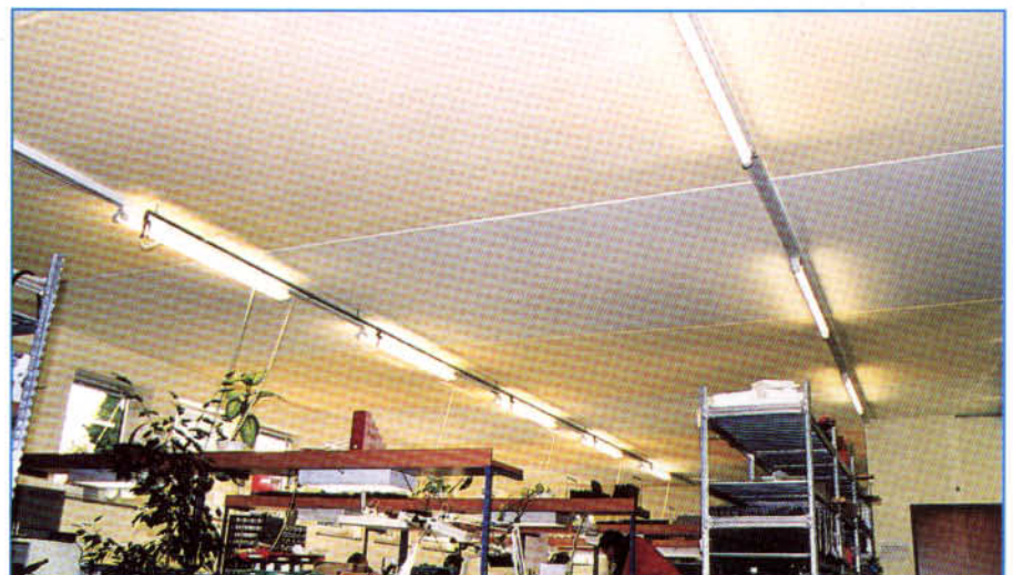
Unterschiedliche Farbgebung der ABE-Deckenplatten und offen gelassene Fugen betonen die Gliederung der Raumdecke im Produktionsbereich.
